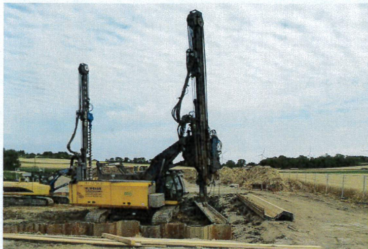
09.07.2019: Spundwandaarbeiten für Baugrubensicherung
