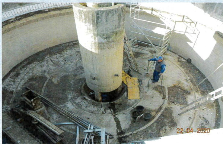
22.04.2020: Demontage NKB alt für Umbau zu RÜB2
