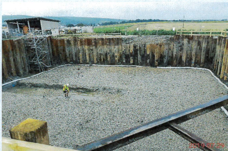
29.07.2019: gesicherte Baugrube mit fertiger Rollierung
