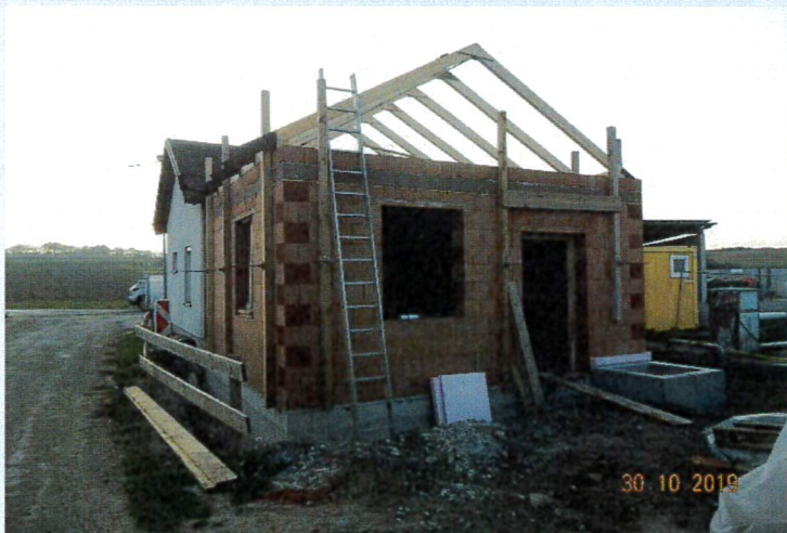
30.10.2019: Betriebsgebäude Zu- und Umbau
