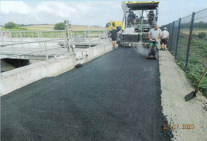
22.07.2020: Kläranlage Asphaltierung Außenanlagen
