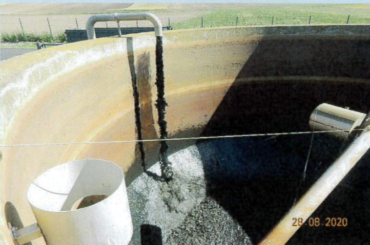
28.08.2020: SSB1 Befüllung mit Überschussschlamm
