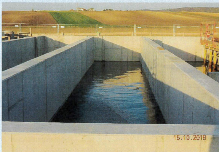
15.10.2019: BB+NKB Füllprobe zur Dichtheitsprüfung
